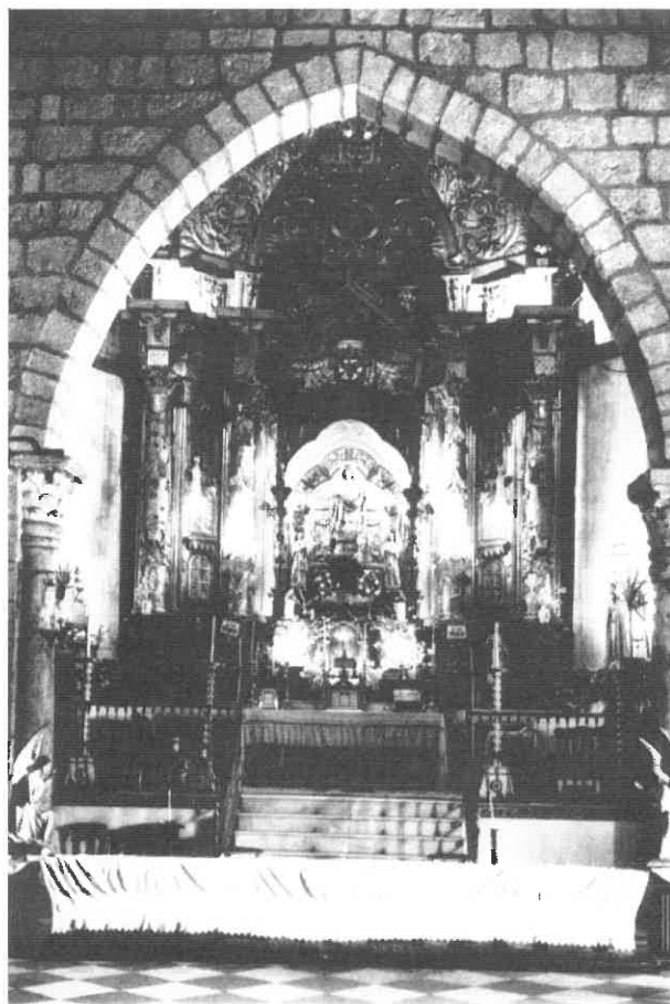
Interior de la Basílica, antes de la reforma.
