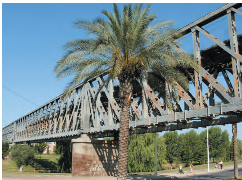
Santa Eulalia puente de hierro entre todos los emeritenses
