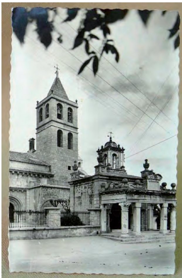
Lío de cables eléctricos, años treinta del siglo XX.
