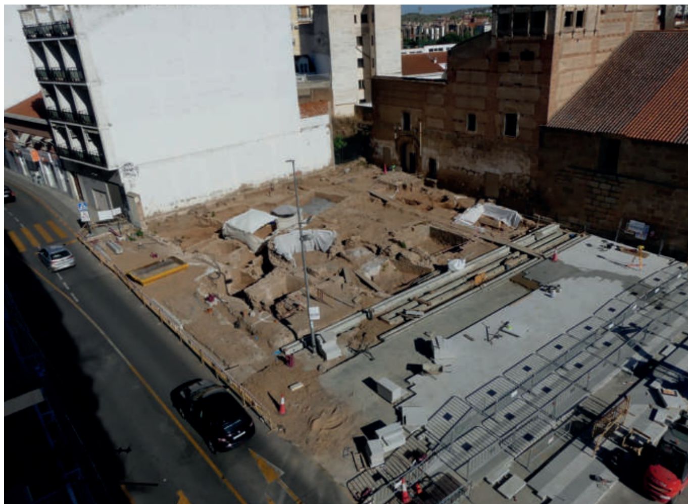
▲ Fig. 1. Vista general del proceso de obra.
