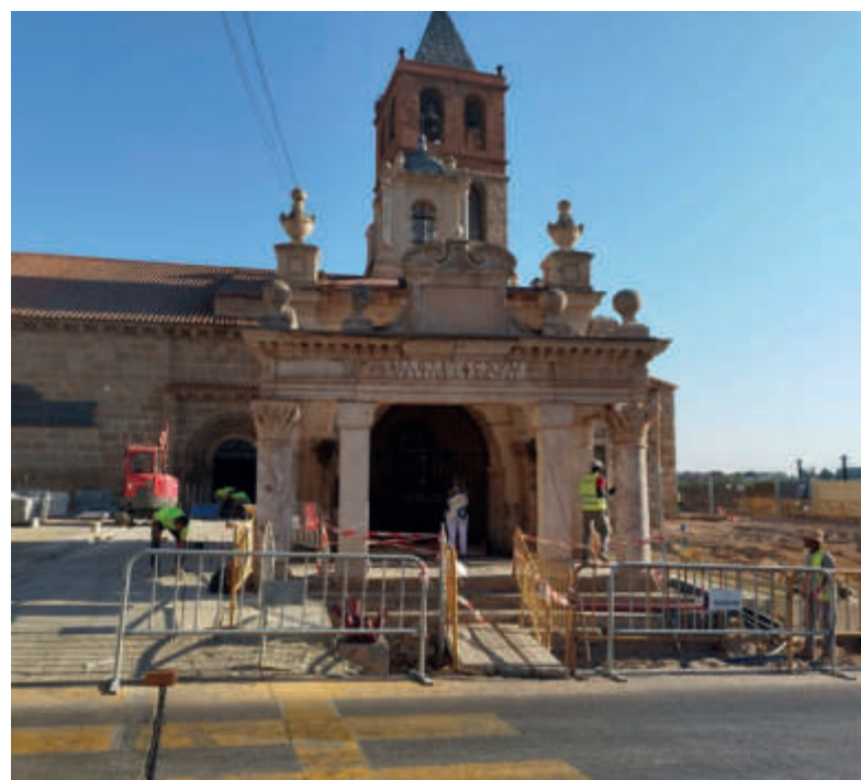
▲ Fig. 4. Feligreses en el Hornito en pleno proceso de obras.
