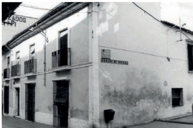
▲ Fig. 4. Casa solariega –desaparecida– de Moreno de Vargas en la calle Santa Eulalia. Foto: M. de la Barrera Ocaña, 1974.
